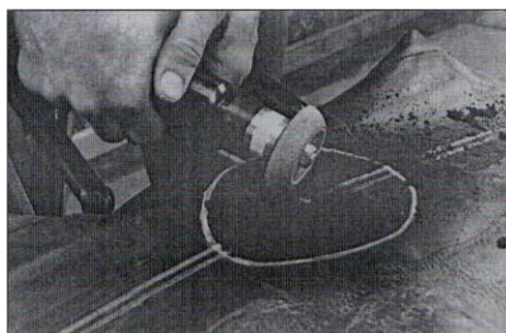
8 Mehāniski notīrīt marķēto laukumu, noņemot izciļņus un padarot virsmu raupju.
